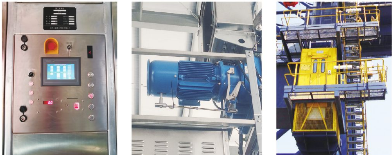
控制面板 Panel 离心限速器 Centrifugal brake 层门 Landing door
